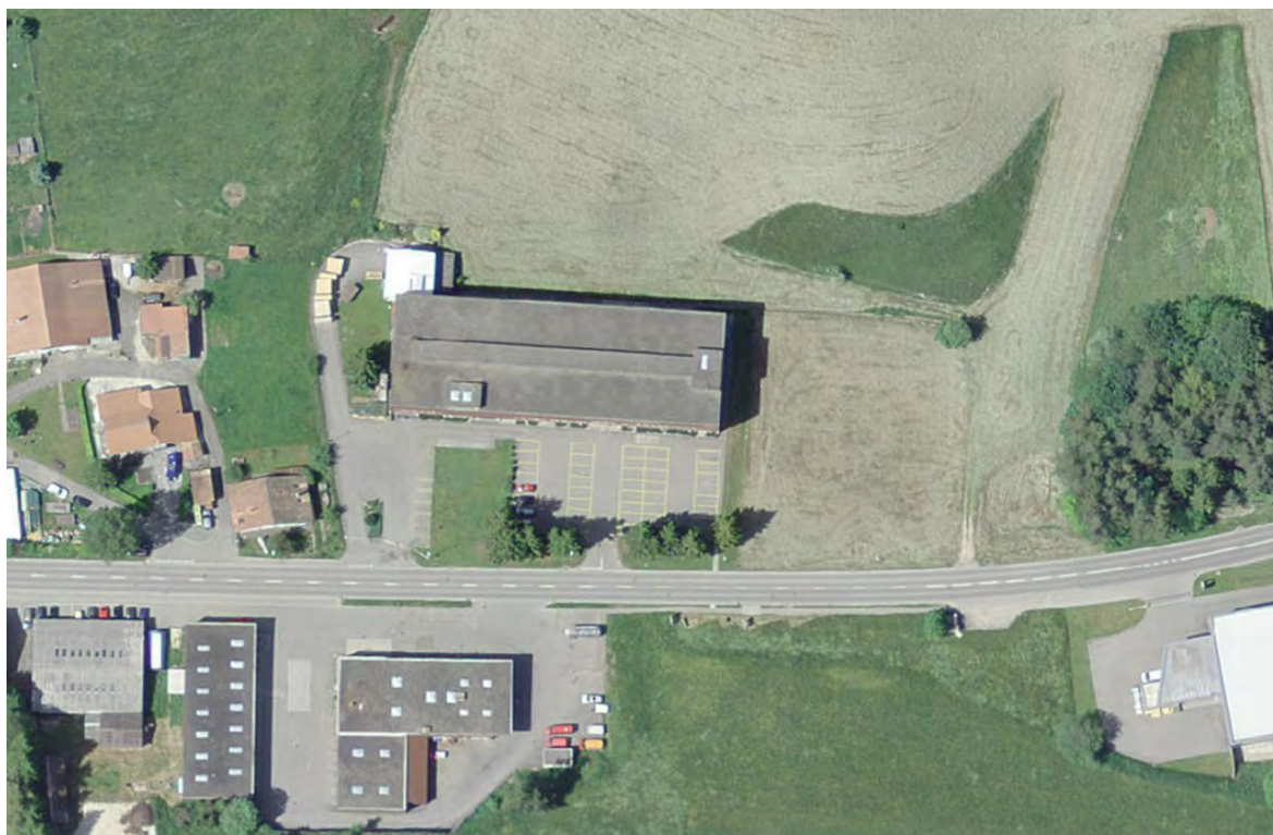
ill. 3.3 : Precitrame Grand' Rue 6 avant l'extension du bâtiment (orthophoto 2014).
