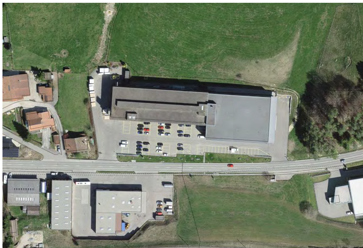
ill. 3.1 et 3.2 : Precitrame Grand' Rue 6, site 'Sulzer' (en ill. 3.2, orthophotographie 2018).
